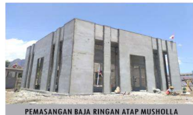
PEMASANGAN BAJA RINGAN ATAP MUSHOLLA
