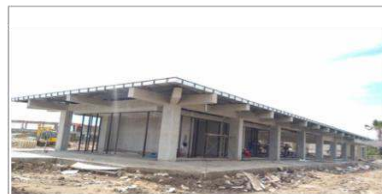
Pekerjaan Arsitektur Bangunan Terminal
