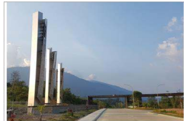
Pekerjaan Menara Tasbara
