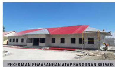
PEKERJAAN PEMASANGAN ATAP BANGUNAN BRIMOB
