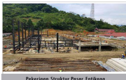
Pekerjaan Struktur Pasar Entikong
