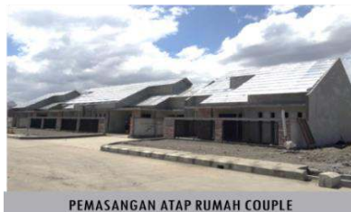
PEMASANGAN ATAP RUMAH COUPLE
