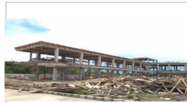
Pekerjaan Struktur Bangunan Pasar
