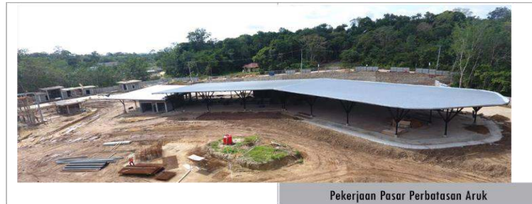
Pekerjaan Pasar Perbatasan Aruk
