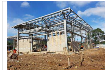
Pekerjaan Bangunan Gereja
