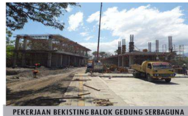
PEKERJAAN BEKISTING BALOK GEDUNG SERBAGUNA
