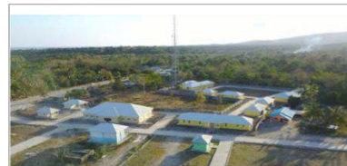
Pekerjaan Komplek Bangunan Pos Pantas POLRI
